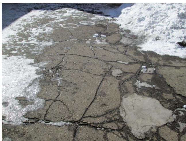
Фото № 2 Асфальтовое покрытие
